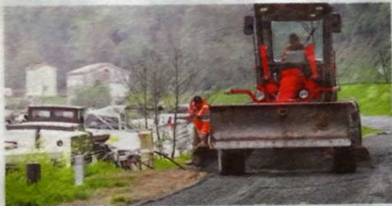
Le centre routier départemental en plein travail.
