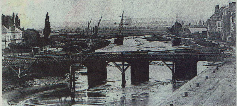
Photo très rare. 1869. Le pont de Saint-Nicolas est en reconstruction, d'où la passerelle. Dans le vieux port, deux voiliers échoués sur les vases ; et dans le chantier naval, un bateau en construction ou en réparation.
